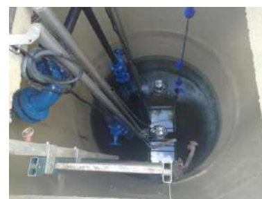
Remise en eau et remise en service du PR
