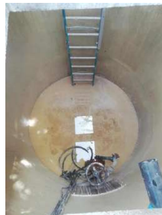
Réalisation des travaux d'étanchéité (1ère couche)
