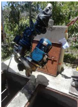
Extraction de l'ancienne pompe
