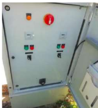
Pose des nouveaux coffrets de commandes
